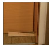
**2. Plaats de deurkast en later ook de deurlijsten en listel 1mm van de grond om later contact met water te minimaliseren. Plaats de deurkast met behulp van een waterpas in de muuroping. Beide onderzijden van de 2 benen van het dagstuk dienen horizontaal op gelijke hoogte in de muuroping bevestigd te worden.**
