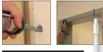
*Spuite de montage lijm op de zijkant van de deurkast en breng enkele propen lijm aan op de muur. Bij een eventuele verwijdering van de geplaatste deurlijst met MONTAGELIJM kan deze met een scherp voorwerp los gesneden worden.*
