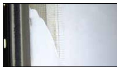
7. Bestrijk de 3° geschuinde kant van het dagstuk en de 6 mm tot 25 mm muuroping op met jointfiller zodat muur en dagstuk één geheel worden.
